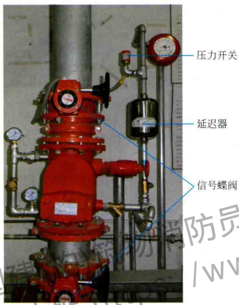
图 10-17 湿式自动喷水灭火系统
