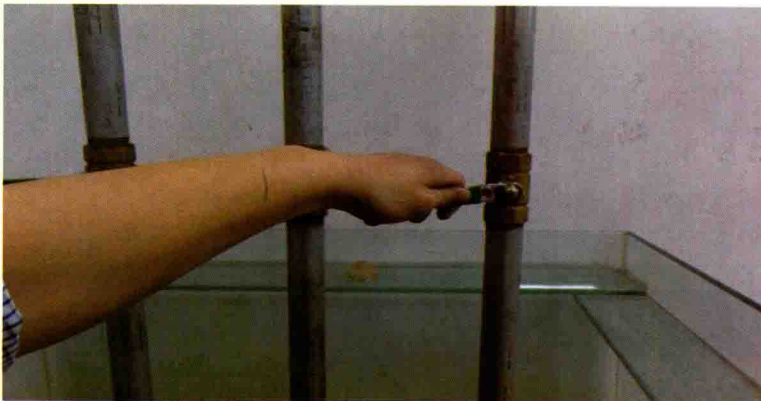
图10-28 关闭末端试水阀门
