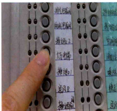
图 10-60 按下多线制控制盘上的电梯按钮
