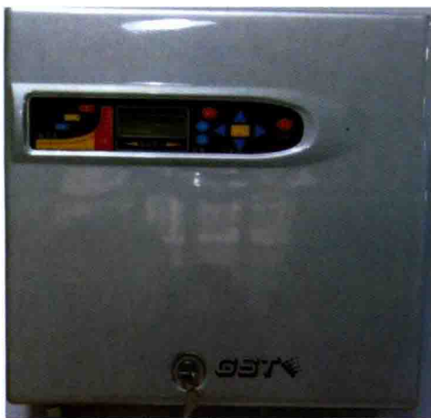
图9-94 空气采样感烟探测器
