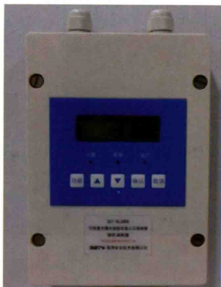
图 9-89 可恢复式缆式线性定温火灾探测器
