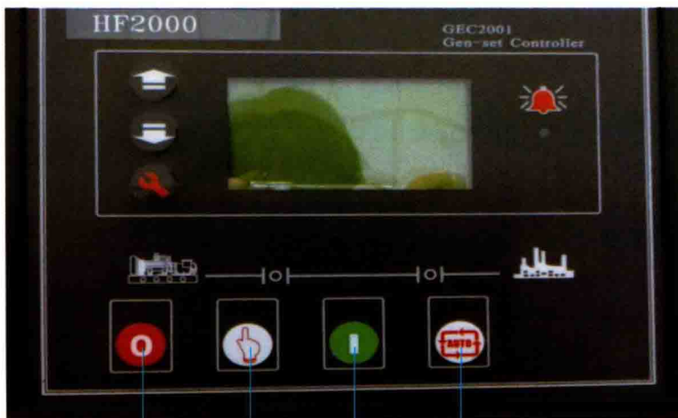
图 10-69 发电机开关按钮
