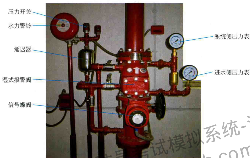
图10-21 湿式自动喷水灭火系统
