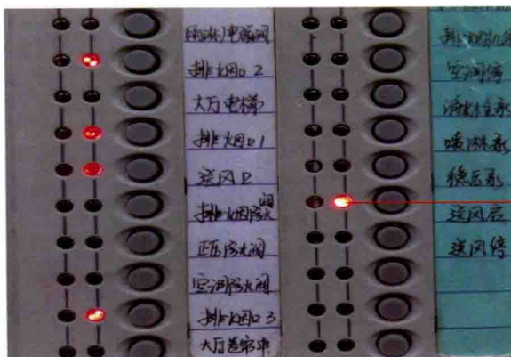
图9-71 消防手动控制盘上显示送风机启动
