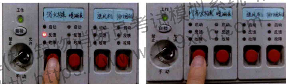
图 9-66 停止消防水泵
