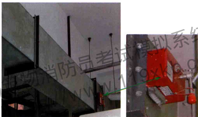
图 10-51 正压送风系统防火阀
