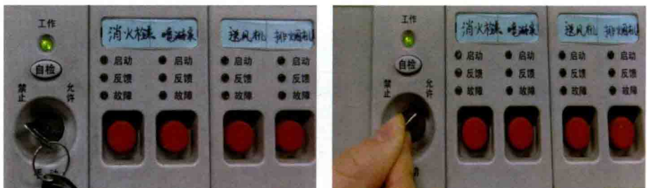
图9-61 将多线制控制盘由禁止状态切换到允许状态
