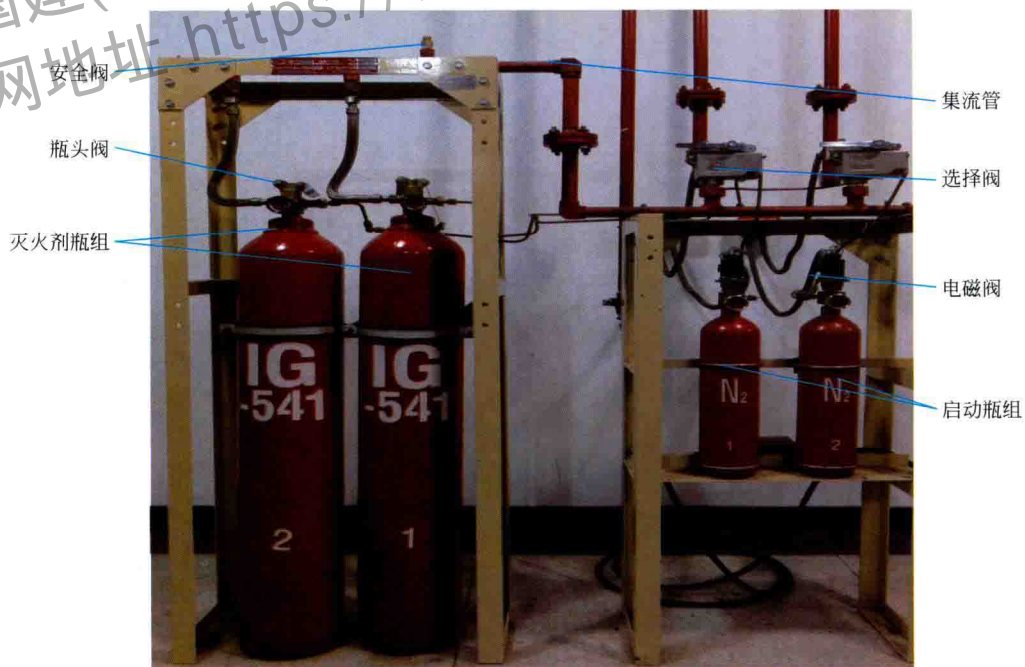
图 10-47 IG-541储气瓶式灭火系统
