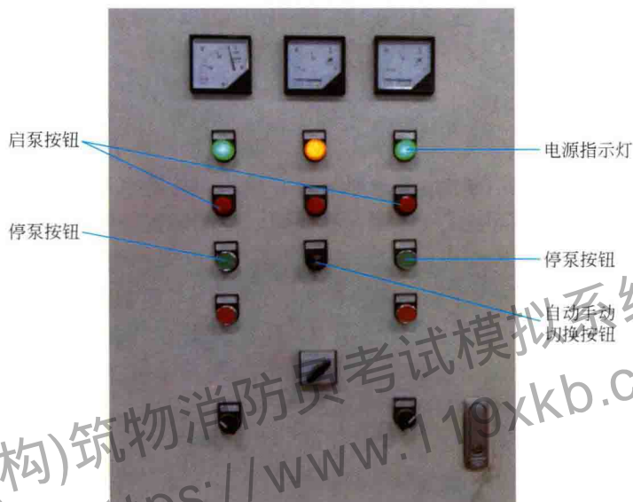
图 10-34 水泵控制柜
