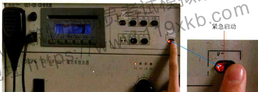
图9-54 再打开“紧急启动”按钮
