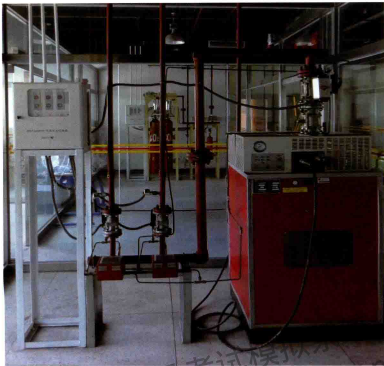
图 10-46 低压二氧化碳灭火系统
