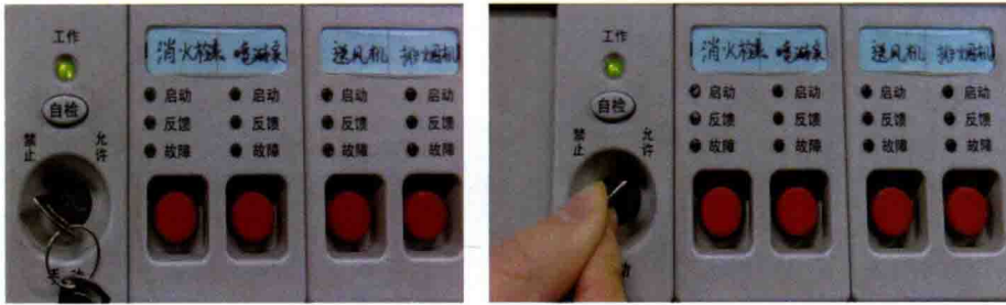
图9-68 多线制控制盘由禁止状态切换到允许状态
