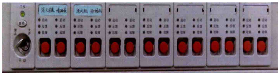
图 9-67 多线制控制盘
