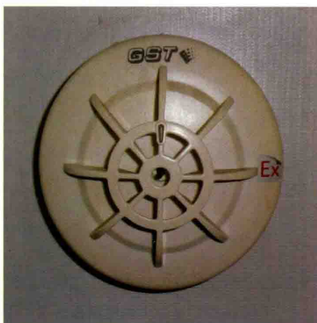
图9-84 感温探测器 (本安型)
