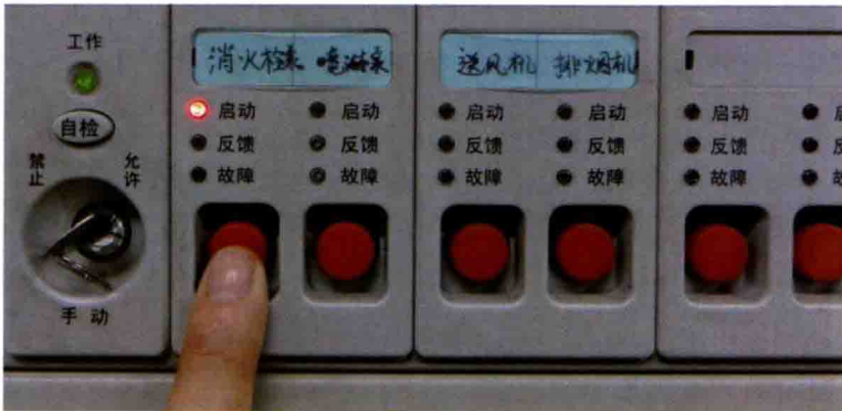
图 9-62 多线制控制盘启动消火栓泵
