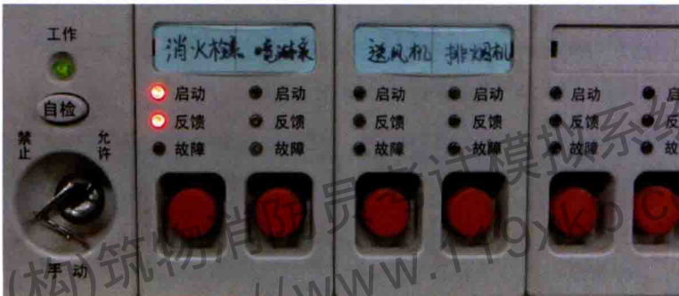
图 9-63 消火栓泵启动反馈信号
