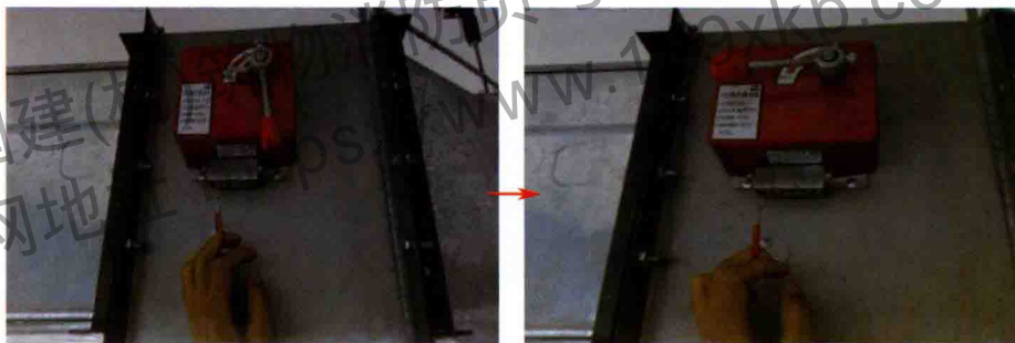
图 10-54 手动关闭防火阀
