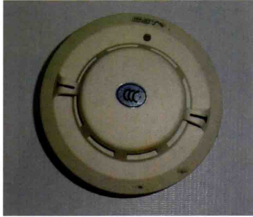
图9-78 烟温复合探测器
