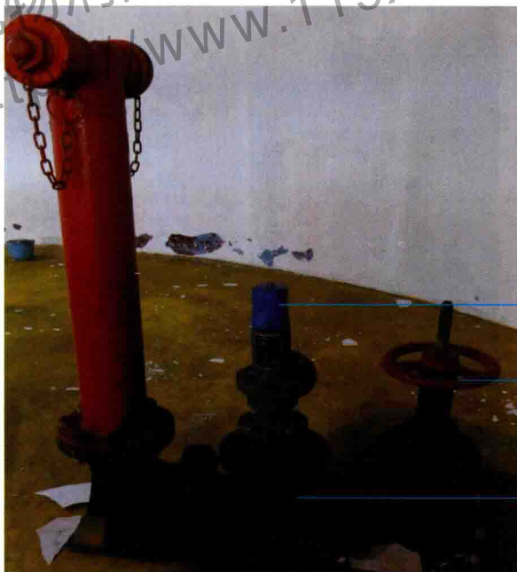
图 10-40 水泵接合器
