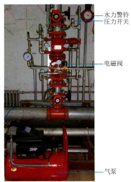
图 10-20 预作用自动喷水灭火系统
