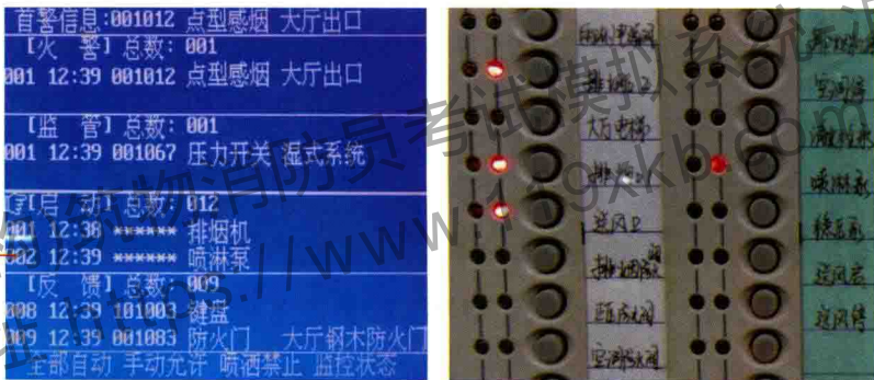
图10-27 喷淋水泵启动的反馈信号
