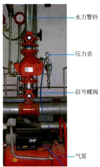
图 10-19 干式自动喷水灭火系统
