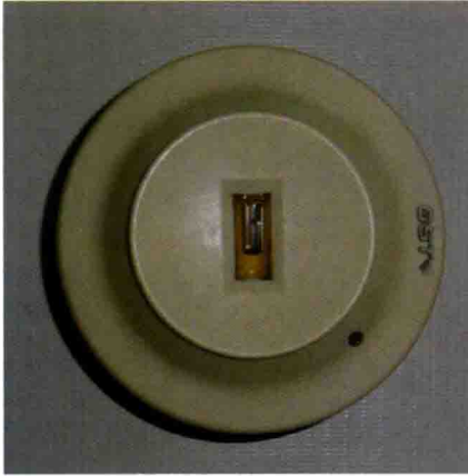
图9-77 紫外火焰探测器
